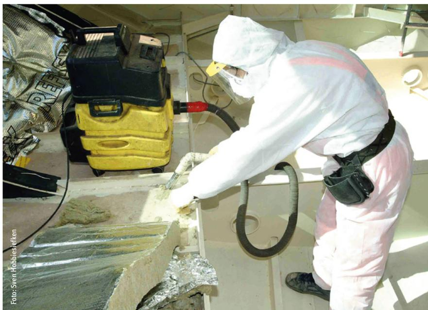
Bei Abbruch- und Sanierungsarbeiten mit Asbest sind Maßnahmen zum Schutz der Beschäftigten – wie Persönliche Schutzausrüstung – unbedingt zu treffen
