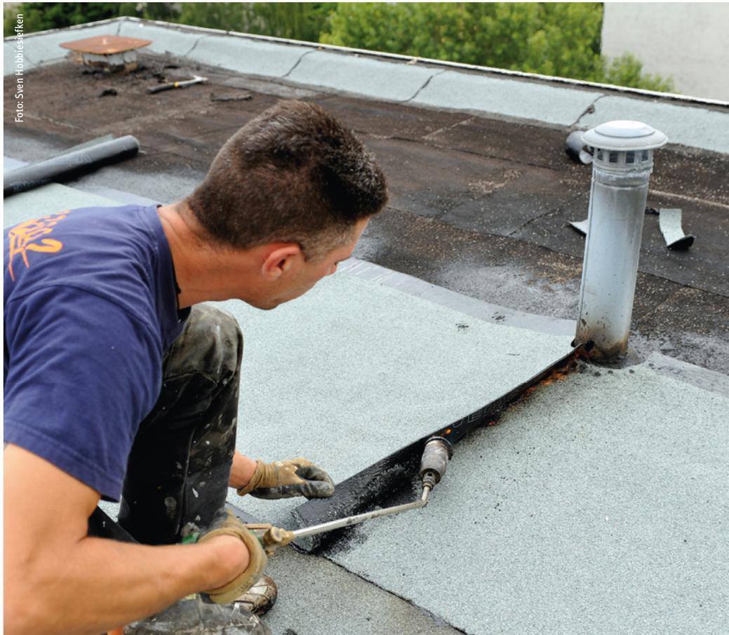
Teer enthält einen hohen Anteil von polyzyklischen aromatischen Kohlenwasserstoffen (PAK), deshalb ist seine Verwendung in Dachpappe seit 1970 verboten
