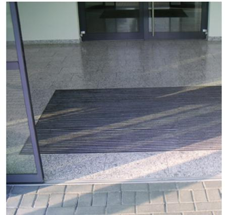
**Abbildung 10:** Auch für nicht behinderte Menschen nimmt bei einer Automattür ohne Schwelle die Stolper- und Sturzgefahr erheblich ab
