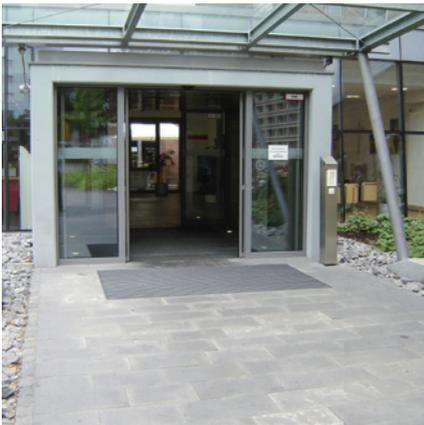
**Abbildung 8:** Schwellden- und stufenloser Haupteingang mit ausreichend Bewegungsfläche
