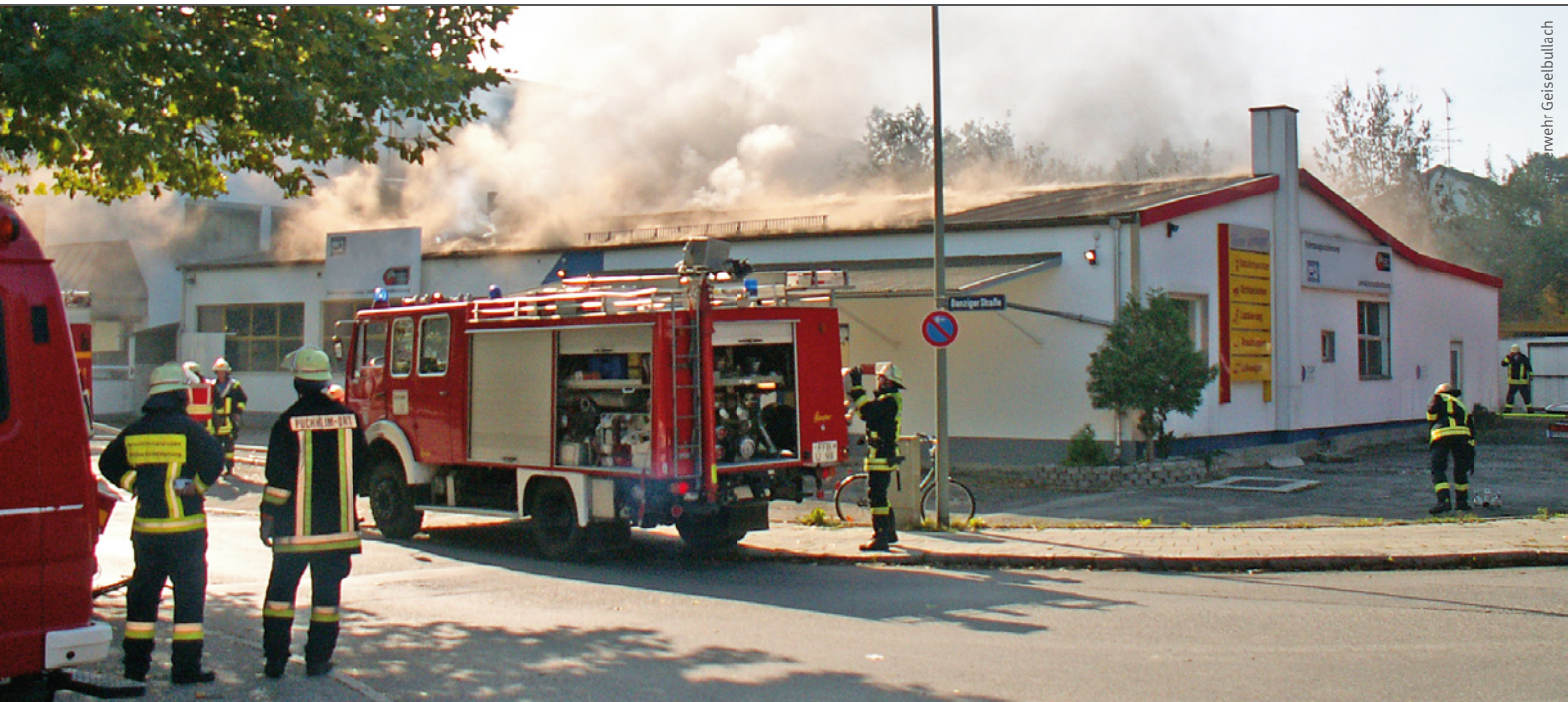
Brandeinsatz – Der Führungsvorgang „Lagefeststellung, Planung und Befehlsgebung“ nach Feuerwehrdienstvorschrift ist hier der Gefährdungsbeurteilung gleichwertig.
