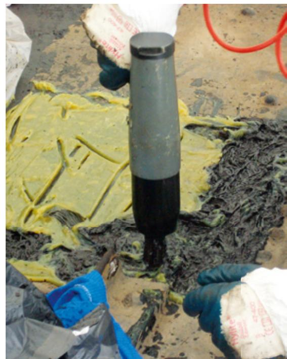
Abbildung 1: Reinigung eines Schleusentores nach dem Pastenverfahren.
